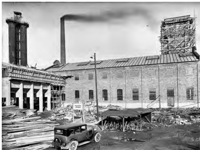
Sulfatmassafabriken i Korsnäs under byggnad 1915.
