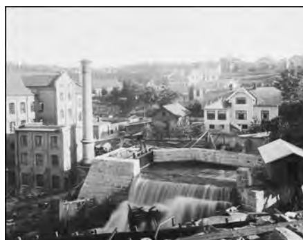
Fordelingsdammen i Tistedalsfossen fordelt vannkraft til Halden Bomulds-spindleri og Vaveri, til Cathrineholm Jernverk og til saugbruket. Foto fra før 1900. (Foto: Halden Historiske Samlinger.)
