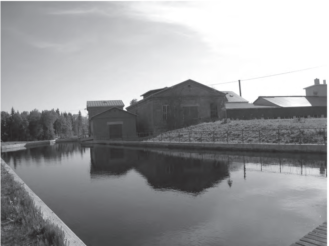
Övre bassängen med damm. Till vänster det nya kraftverket, byggt i mitten av det förra årtiondet. Sliperiet i mitten och en del av kartongsalen till höger. Foto: Sirkka-Liisa Sihvonen.
