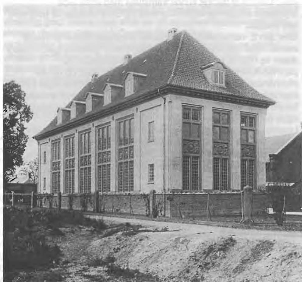
Seddelfabrikken på Silkeborg Papirfabrik opført 1910.
