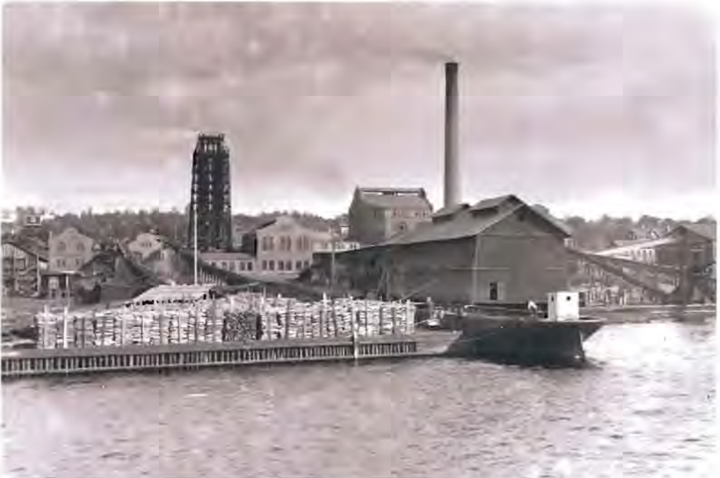
Den klassiska siluetten av en sulfittfabrik, dominerad av syroronet. De torn i trä som uppfördes under nybyggnadsperioden, ersattes från slutet av 1920-talet vid de allra flesta fabriker av gjutna betongtorn. På bilden, som togs 1916 i Söråker vid Indalsälvens utlopp, finns trätornet fortfarande kvar. I förgrunden pågår vedlossning från pråmen "Söråker" (f.d. kanonbåten "Motala").
