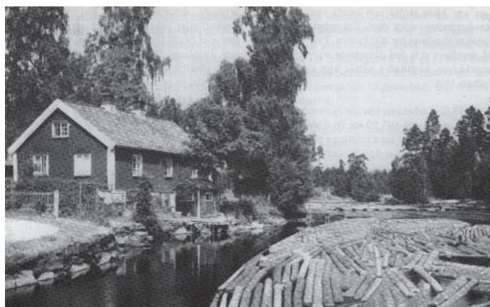
Vy uppströms dammen i Skåpafors. I byggnaden låg postkontoret. Källa: Pappers avd. 119 Skåpafors 75 år 1919-1994.
