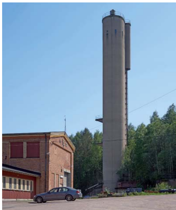
Det nya syratornet som byggdes 1961 står ännu kvar på fabriksområdet som ett monument över en svunnen industriepok. (Foto Bo Edlund 2016)
