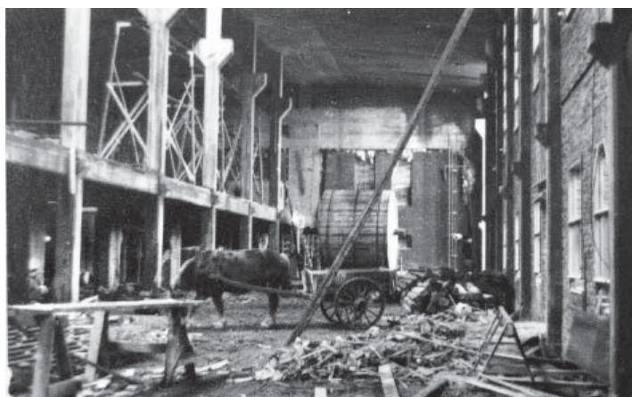
Anläggande av Västra Bruket, 1930. Hästar var det viktigaste transportmedlet. I bakgrunden en yankeecylinder i väntan på montering (ur Hammarö Hembygdsförenings fotoarkiv).
