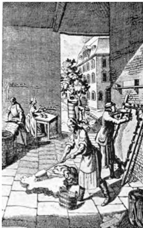
Beredning av pergament. Skinn från kalv eller får behandlas i kalkbad, spänns upp, skrapas rena, och gnuggas med pimpstenspulver och någon form av vit färgpasta.
