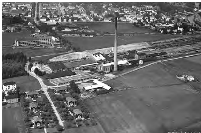
Örebro pappersbruk med sin berömda skorsten, Sveriges då högsta, som byggdes för att minska olägenheterna i Örebro med lukten från sulfatmassafabriken. Detta var resultatet av en långvarig konflikt och ledde till att man till slut lade ned massafabriken 1941 och ökade massakapaciteten i Frövifors för att kunna försörja båda pappersbruken med massa därifrån.
