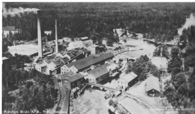
Flygbild över bruket 1923. De fyra pappersmaskinerna fanns i byggnaderna till höger med sulfatmassafabriken bakom.
