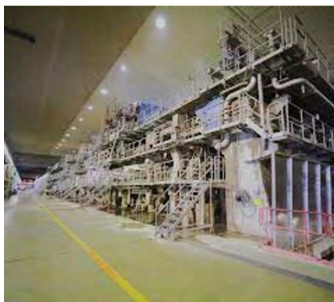
KM5 i Frövifors som byggdes för 160 000 årston och idag har en kapacitet på 500 000 årston.
