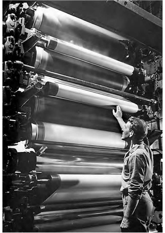
En superkalander för tillverkning av pergamyn. Papperet passerar genom flera valsnypp där i varje valsnypp den ena valsen är en hård blank stålvals och den andra utgörs av ett hårt sammanpressat mjukare material, i detta fall asbest. Genom att den mjukare valsens yta deformeras något vid valsningen blir effekten att pappersytan utsätts för gnidning, vilket ger en mycket slät och glansig yta. Hela stapeln av valsar utsätts för ett högt tryck så att papperet komprimeras, blir tunnare och får en hög densitet, i vissa fall över 1000kg/m 3 . (Foto K.W. Gullers, Billeruds arkiv)
