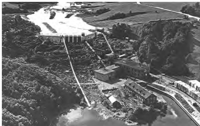
Rottneros Bruk 1930. För att kunna utnyttja fallhöjden bättre byggdes 1925 den så kallade Rottnadammen som syns på bilden.
