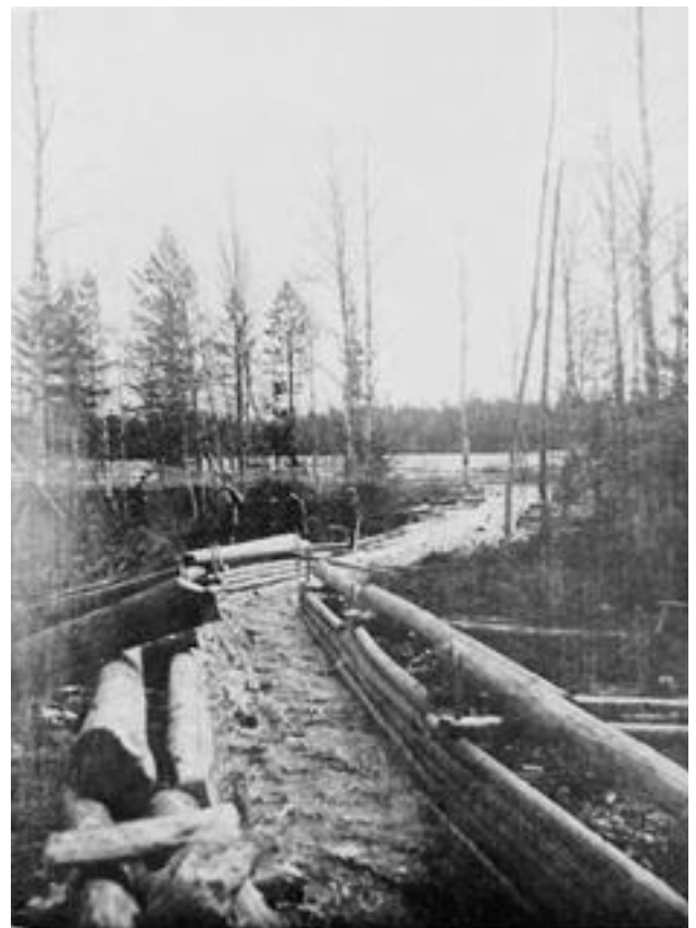
Timmerränna för flottning av virke förbi forsar. (Bilden ur Hovings historik (1).)
