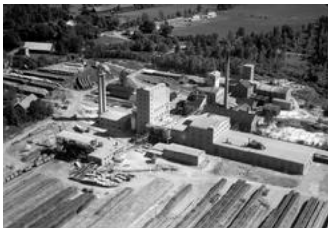
Böksholms sulfitmassafabrik 1956 med de för gamla sulfitfabriker enorma virkeslagren.
