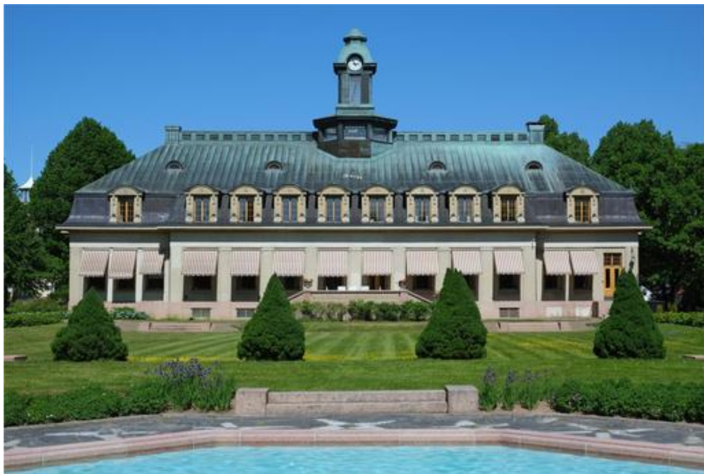
Kontorsbyggnaden i Norrmark, byggd 1914. (Bilden från "kallerna - Eget arbete, CC BY-SA 4.0.")
