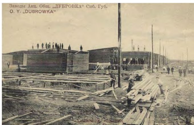
Bilden visar stapling av det sågade virket i Dubrovka. Vagnen som transporterade virket löpte på skenor och drogs ofta av hästar.
