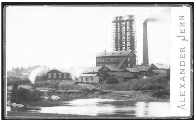
Ett foto av fabriken tagen några år efter starten. Syratonet med sitt typiska mönster av stöttande träkonstruktion reser sig högt över omgivningen. Den höga träbyggnaden framför syratonet är kokoriet, som snart skulle komma att byggas på med en del av tegel.
