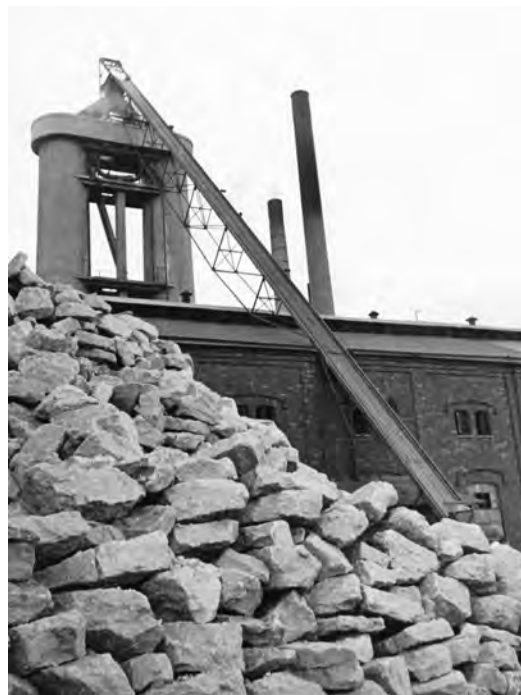
Det gamla syratonet av trä ersattes av ett nytt i betong 1932. Sommaren 1965 fick jag börja mitt praktiskarbete med diverse uppdrag på sulfitfabriken, bland annat med att lasta kalksten i den transportvagn (kallad "hunn" = värmländska för "hunden") som drogs upp till toppen av syratonet och tippade stenarna ned i tornet under ett buller som hördes vida omkring.
