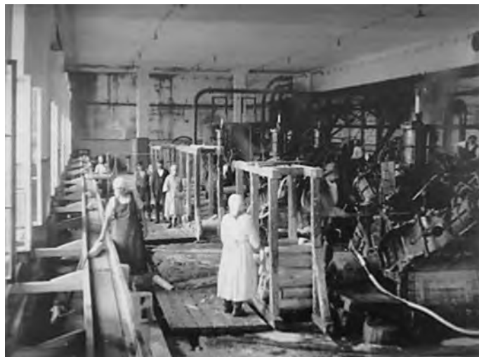
Pankakoski sliperi på 1920-talet. De sågade och barkade vedkubbarna kommer med bandtransport till sliperiet. Slipstolarna till höger i bilden.
