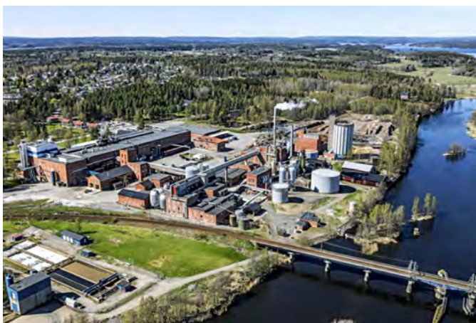
Nordic Paper Seffle på en flygbild från 2021. Sulfittfabriken är den högra delen av anläggningen, pappersbruket den långa byggnaden till vänster. Det randiga tornet längst till höger är hartsognadssilon. Byälven och järnvägen stryker förbi, två viktiga faktorer till att börja bygga fabriken just här år 1883.
