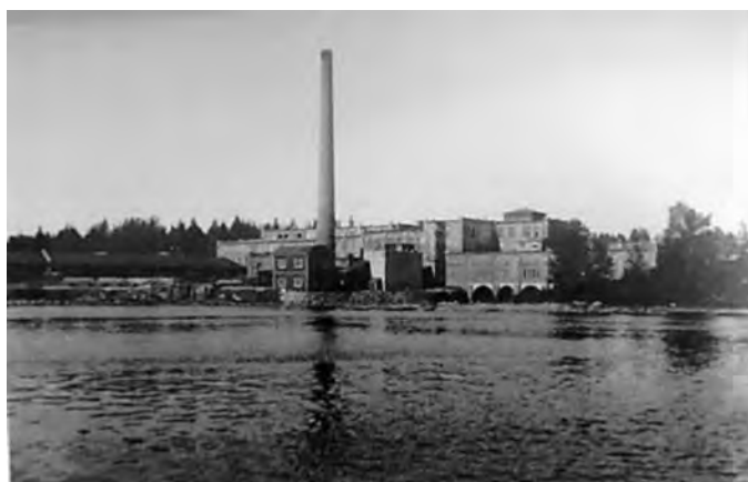
Pankakoski fabrikerna på 1920-talet. Under den högra delen av byggnaden ser man vattenturbinernas utloppsöppningar. Slipstolarna fanns alltså rakt ovanför dessa. Kartongfabriken låg i den höga byggnaden bakom sliperiet.
