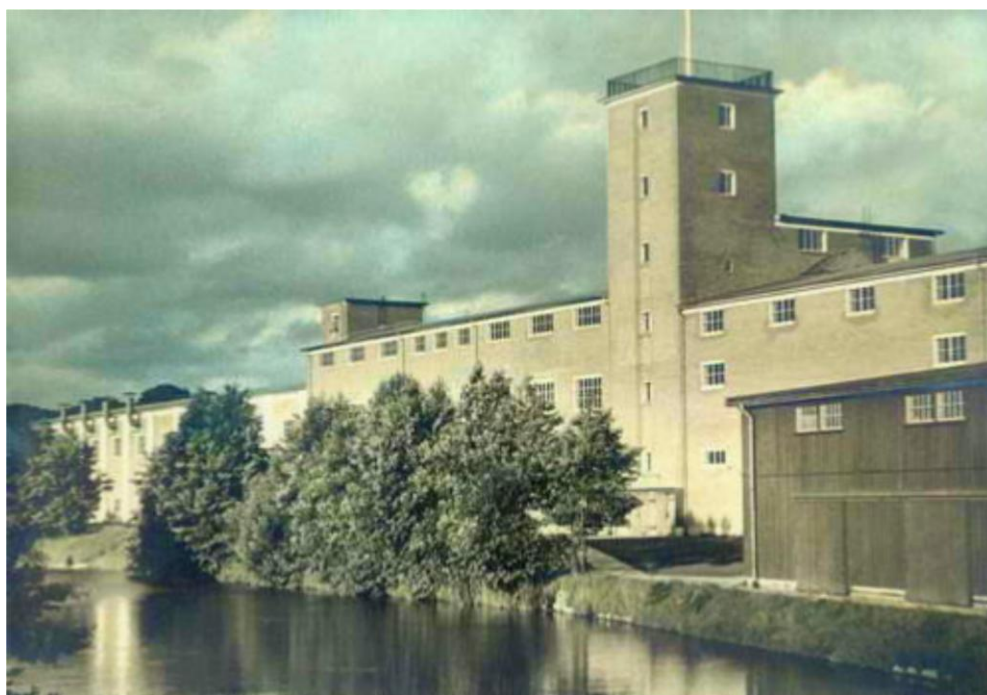
Silkeborg Papirfabrik. Fabriksbygningen til papirmaskine nr. 3 i 1930'ernes arkitektur. (Museum Silkeborg, https://www.museumsilkeborg.dk/silkeborg-papirfabrik-1 2021-10-27)
