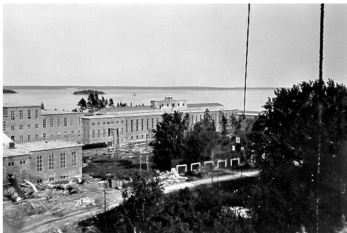
Gruvöns Bruk under byggnad 1931. Projektledare var John Spangenberg. Fabriken byggdes på ett för tiden ovanligt framsynt sätt genom att den skulle kunna utökas utan stora ombyggnader.
