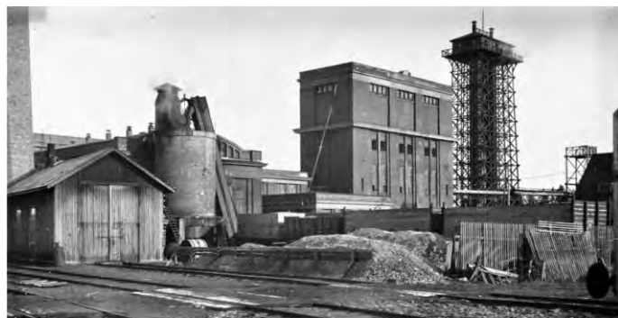
Lielahi sulfitmassafabrik på 1920-talet. Syrratornet till höger, pannhuset i mitten och Nordströms torktorn till vänster.
