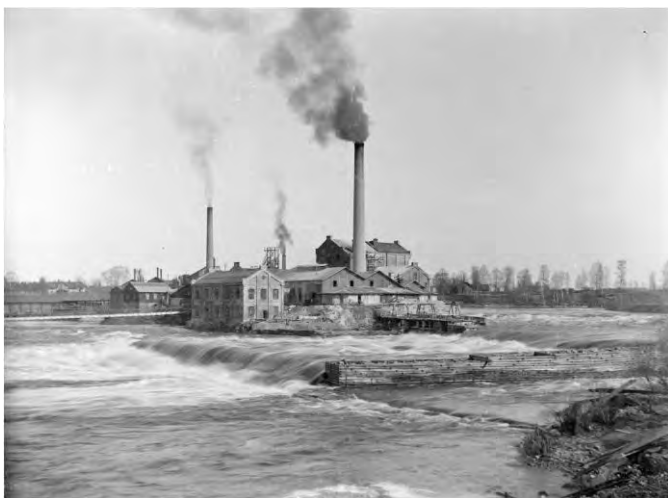
Klarafors sulfatfabrik 1899. Denna anläggning startades 1885 med sodamassatillverkning efter några misslyckade startförsök och byte av kokare.
