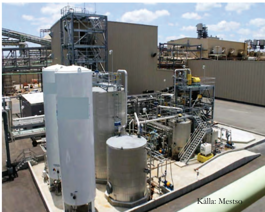
Ligno boost-anläggning, med teknik för att utvinna överskottslignin ur sulfatprocessen
