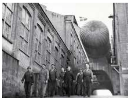
Den Zeppelinerliknande cylindern i bakgrunden är en ångackumulator vid Nensjö sulfatfabrik 1961
