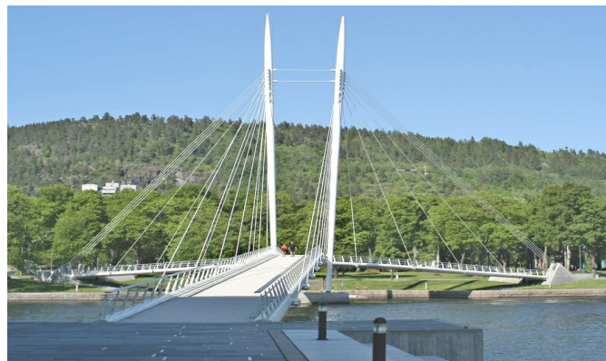
Ypsilon bru, en skråkabelbro over Drammenselva i Drammen. Gangbroen, som knytter sammen den nye Kunnskapsparken på Grønland i Drammen med byparken på Bragernes har fått navnet «Ypsilon» på grunn av sin spesielle form – fra lufta ser den ut som en Y. (Wikipedia, Attribution: I. Peulle)
